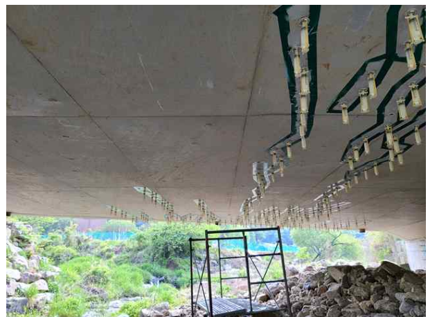
바닥판 S1 균열보수
