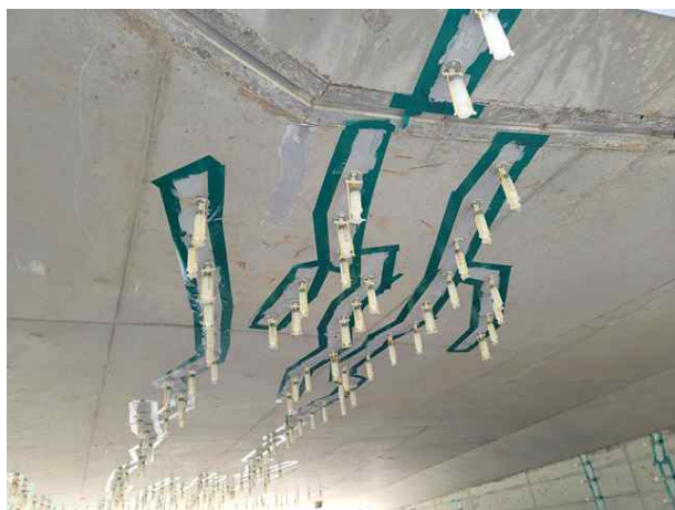
바닥판 S1 균열보수
