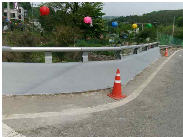
연석 S1 철근노출 파손 보수
